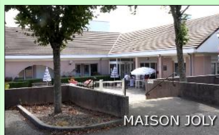
EHPAD « Maison Joly » à Montbéliard
